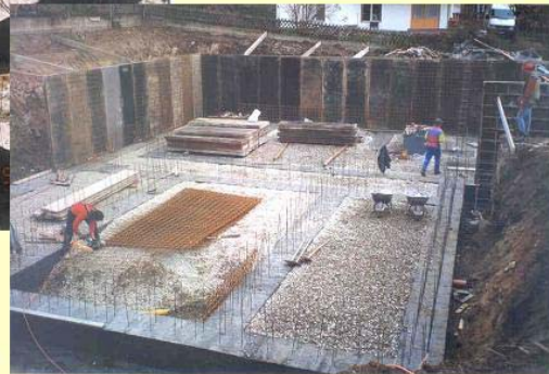
FIGURA 20) Realizzazione pratica di un sistema d'aspirazione dell'aria dal sottosuolo per mezzo di una rete di tubi di drenaggio incorporati nella ghiaia.
